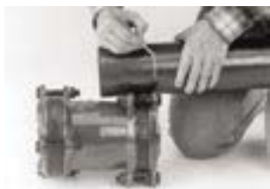
Zjištění hloubky zasunutí
